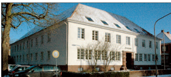
Das alte Finanzamt wird zur Schule umgebaut.
